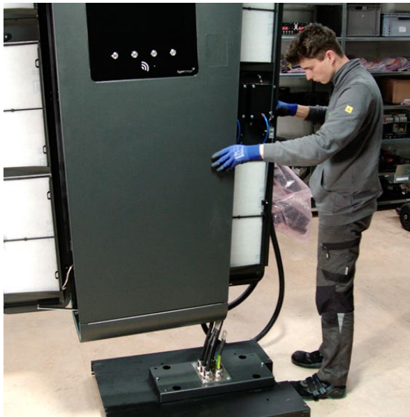
Abbildung 54: Positionierung HYC200 auf Sockel und Befestigung
